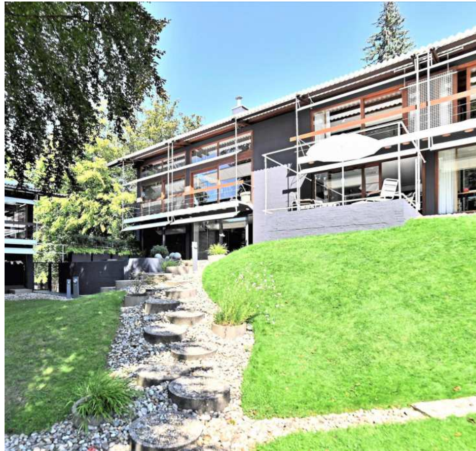
Mit Kies gefüllte Kanalröhren: Die Trittstufen aus Beton im Garten seiner Villa hat Egon Eiermann japanischen Vorbildern nachempfunden. Foto: Ulrich Coenen
